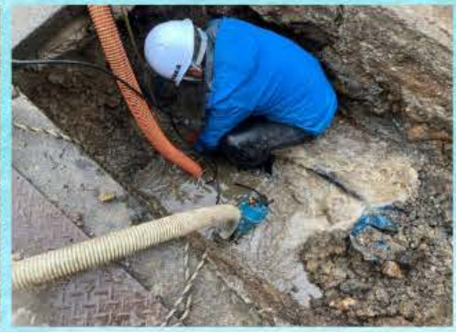
⑥漏水箇所部品取替作業の様子
