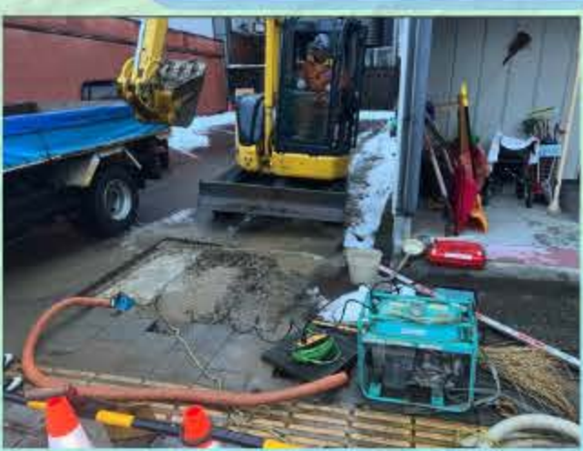
①漏水箇所のアスファルトを切断。 ②埋設土砂を取り除きます。
