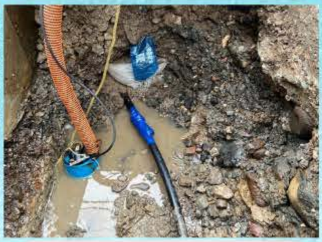
⑦漏水箇所 継手取替作業 完了 防食テープも巻き終わりました。
