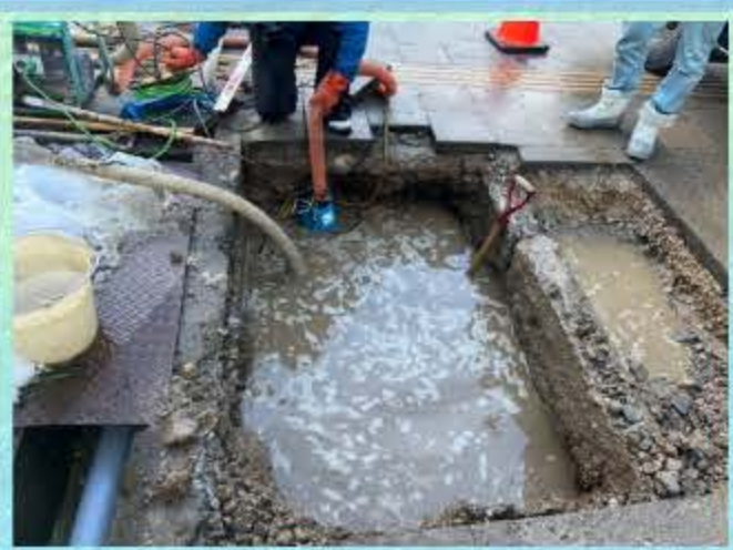
③水を汲み取り、漏水箇所を探します。
