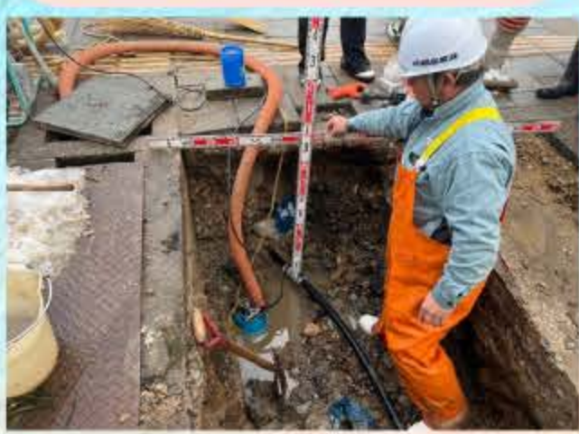
⑧計測⇒管の保護砂を埋めます。
